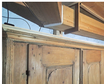
Detail Einbauschränk, nach Ergänzung von Holzfehlstellen am Abschlussgesimse.
