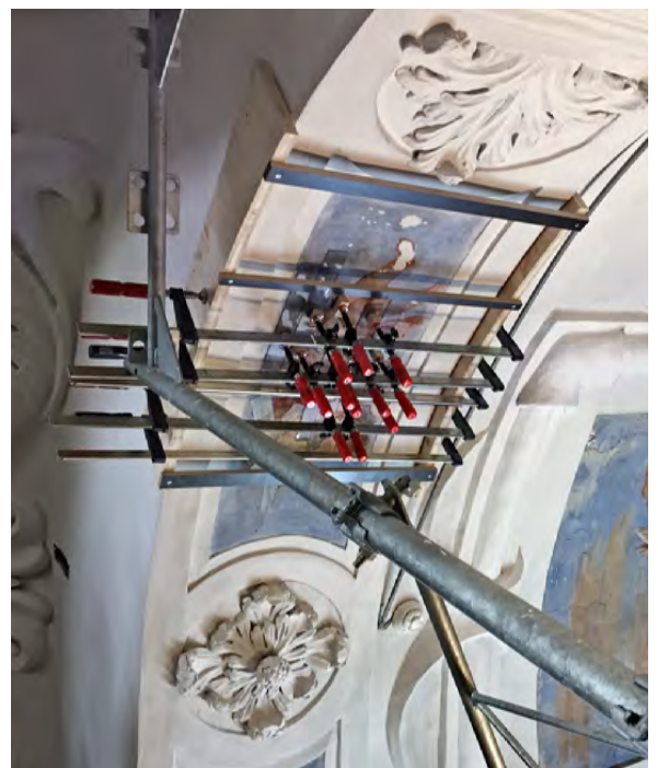
Puttenfresco im Gurtbogen während den Planierungs- und Sicherungsarbeiten.
