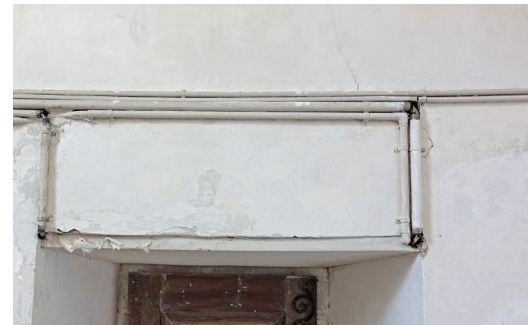
Detail heutige Elektroinstallationen auf den Wandflächen.
