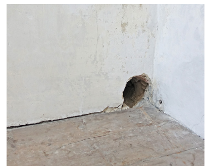
Detail Loch durch Mauerwerk zur Verlegung der neuen Installationen.
