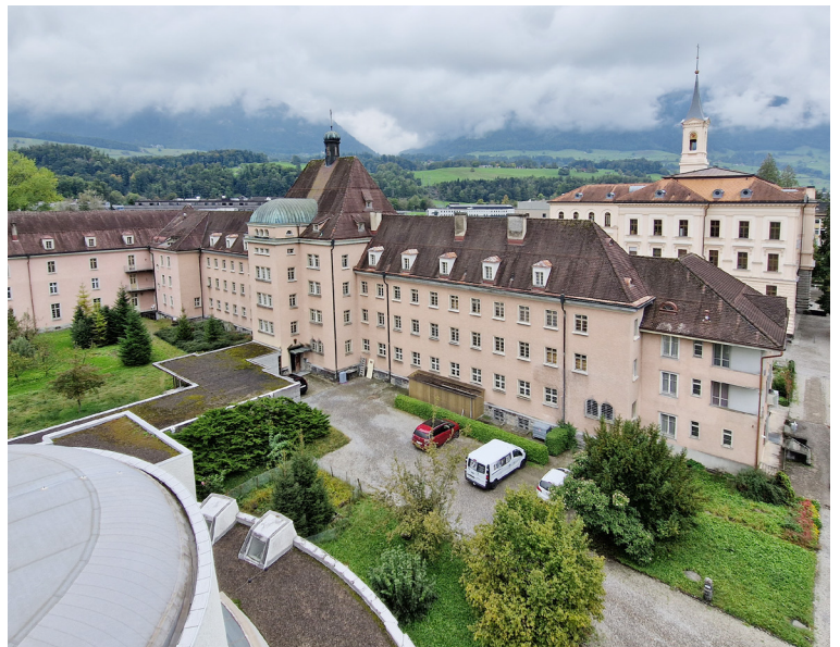
Konventgebäude in Sarnen.
