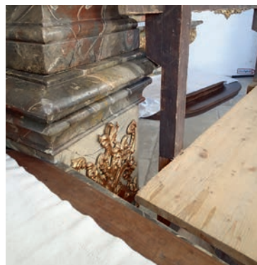
Absturzsicherung, welche praktisch am Altar aufliegt.
