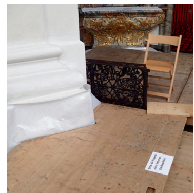
Podestpartie mit Kontakt zu einer Pfeilerbasis.
