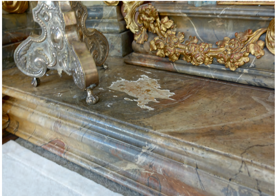
Beispiel für einen Schaden durch Gebrauch auf einer Leuchterbank.
