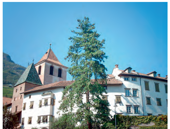
Blick auf die Klostergebäude von Muri-Gries vom Grieserplatz her.
